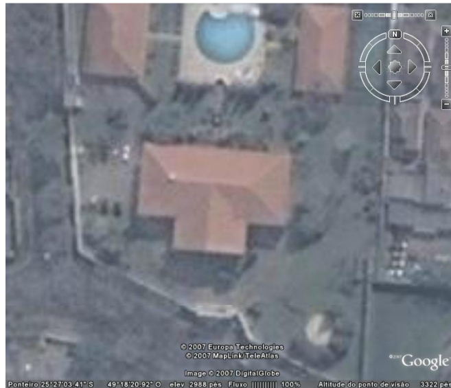
Figura 4: Imagem de uma cobertura, localizada na cidade de Curitiba/PR.
